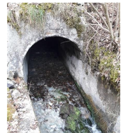
Sortie de la prise d'eau 1938
